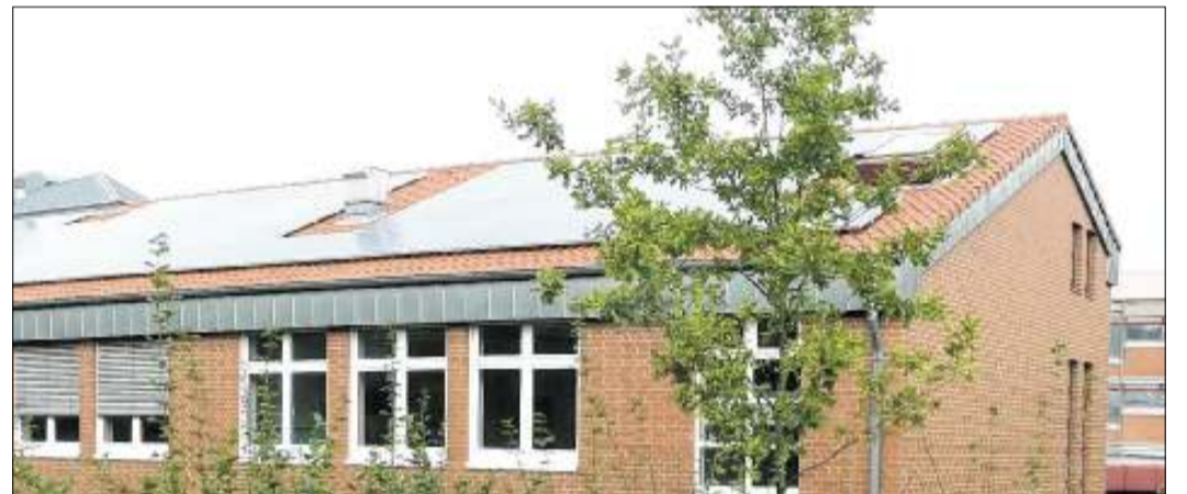
Bürger betreiben seit dem vergangenen Jahr auf dem Dach der Gesamtschule in Lerbeck eine Solaranlage. Minden ist davon noch weit entfernt. Foto: MT-Archiv
